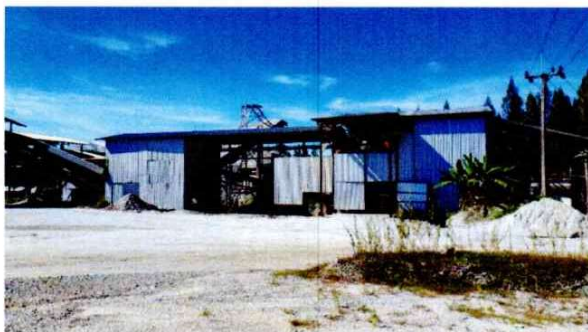
รูปที่ 13 ติดตั้ง Metal Sheet ปิดคลุมอาคารโรงโม่หิน
